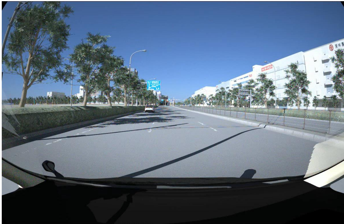
かすれた白線(お台場 青海縦貫道)
