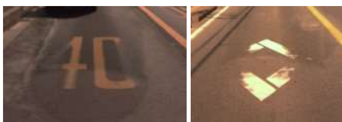
図⑮-2-11： 擦れが認められる道路標示
