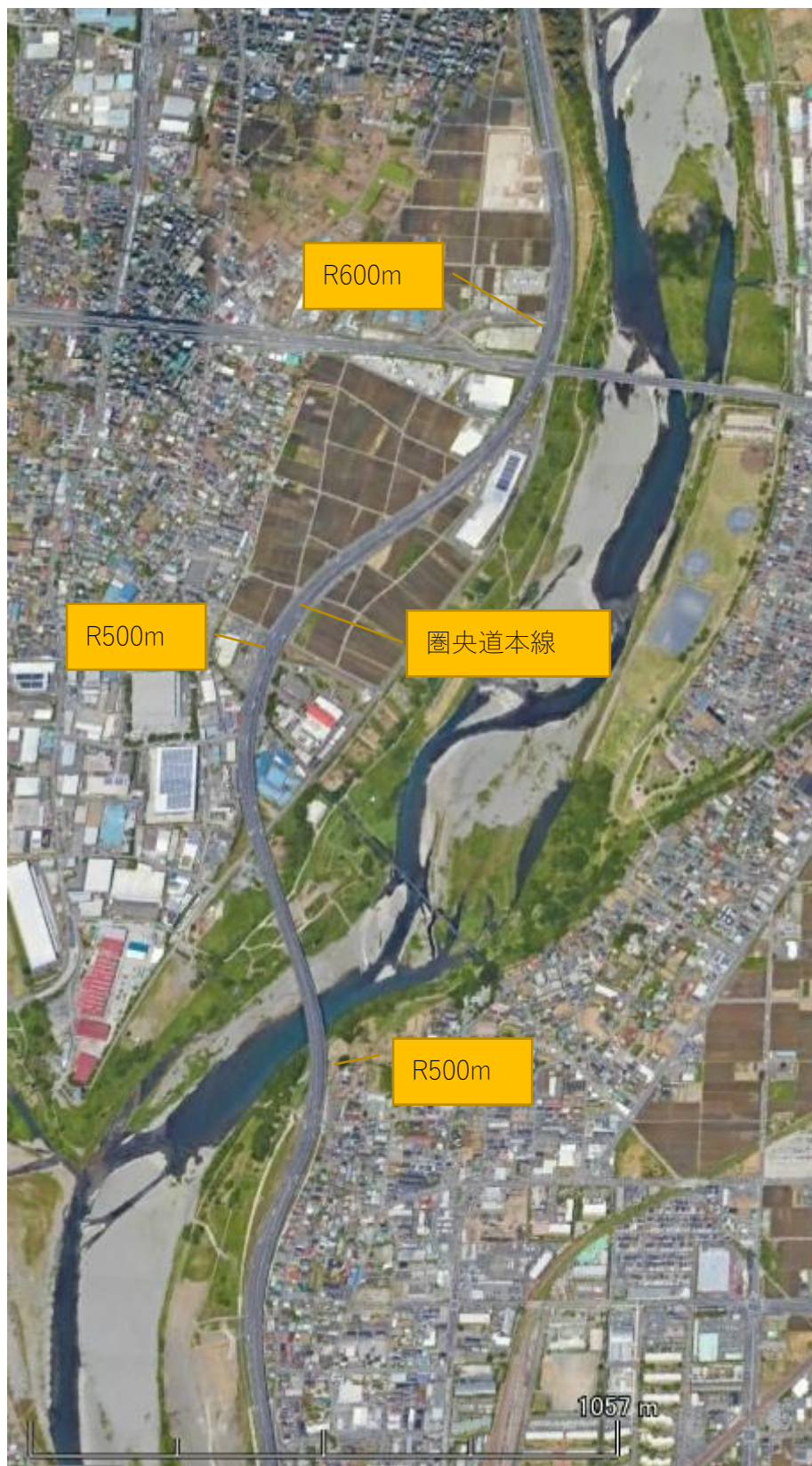
Fig. 6-10 高速コーナー②圏央道相模川付近
