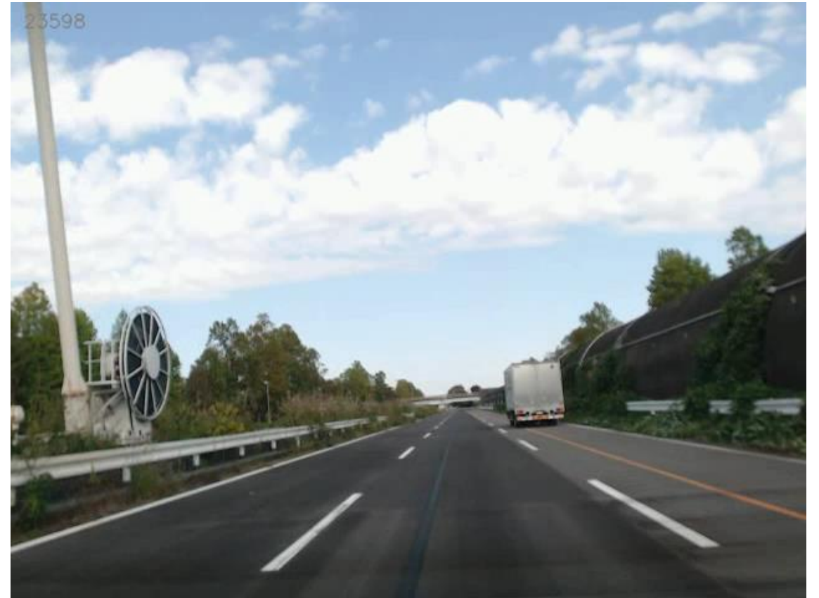
日P車 カットイン システムがブレーキ対応できなかったケース (ドライバブレーキ対応ケース)
